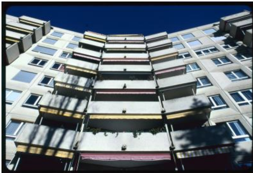
Thônex. Dettaglio dei balconi sulla facciata del Résidence Apollo
