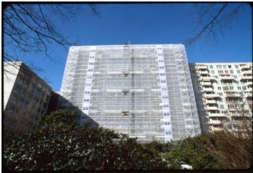
Thônex. Facciata del Résidence Apollo in ristrutturazione
