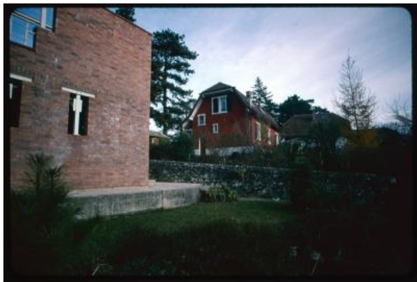
Thônex. Dettaglio di due villette
