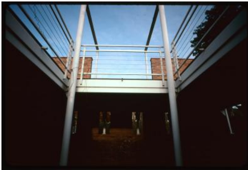
Thônex. Dettaglio del cortile interno di un'abitazione
