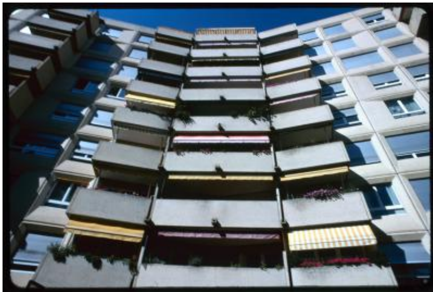
Thônex. Dettaglio della facciata di un palazzo in Avenue Adrien-Jeandin
