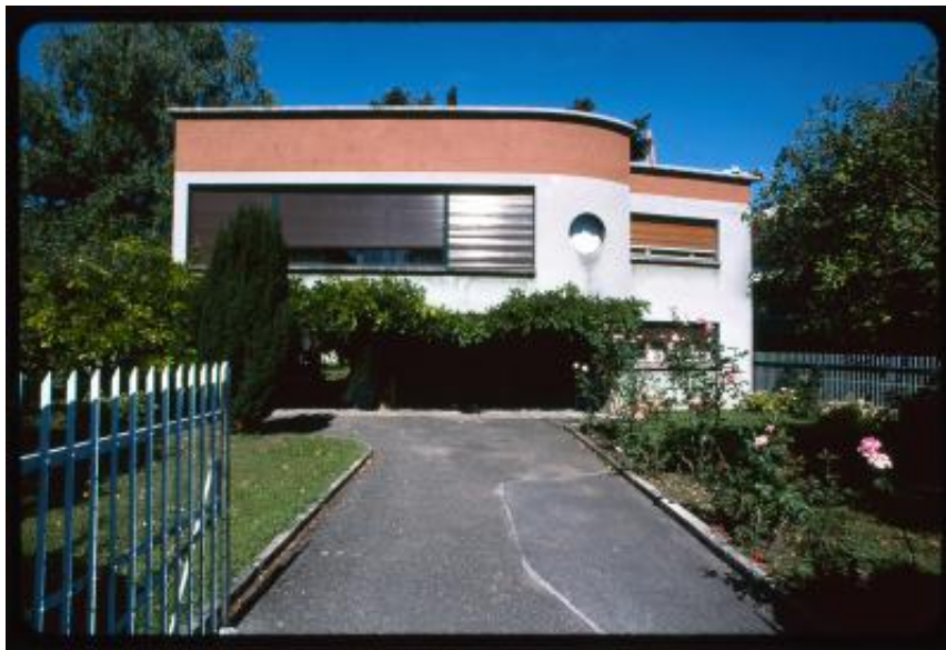
Thônex. Veduta di una casa in Avenue Tronchet
