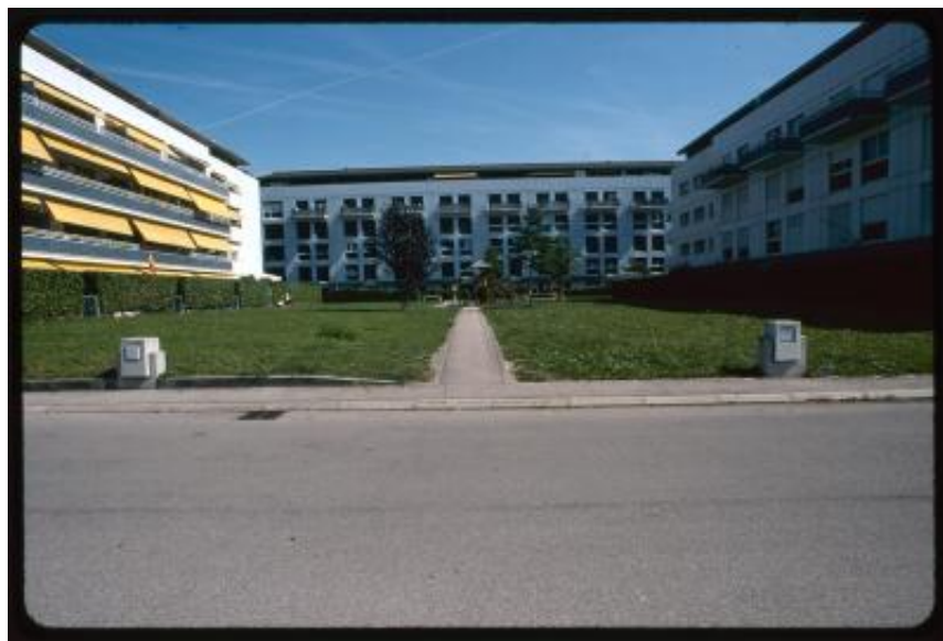
Thônex. Veduta di un complesso residenziale, Les Verchères
