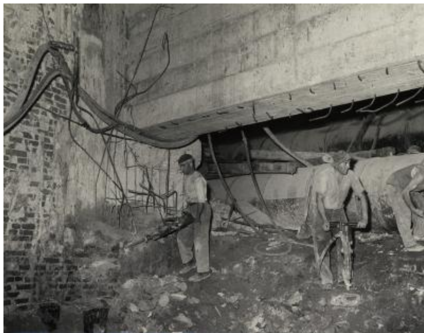
Scavo in sotterraneo al cantiere Naviglio a Milano
