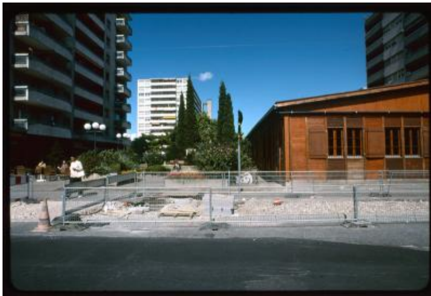
Thônex. Lavori al centro di Rue de Genève all'altezza di Place de Graveson
