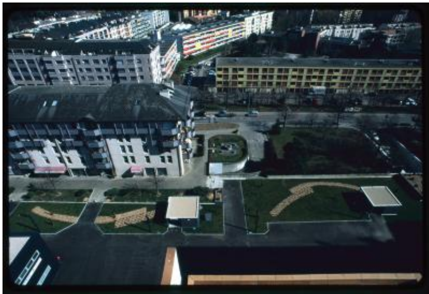
Thônex. Veduta dal tetto del Résidence Apollo
