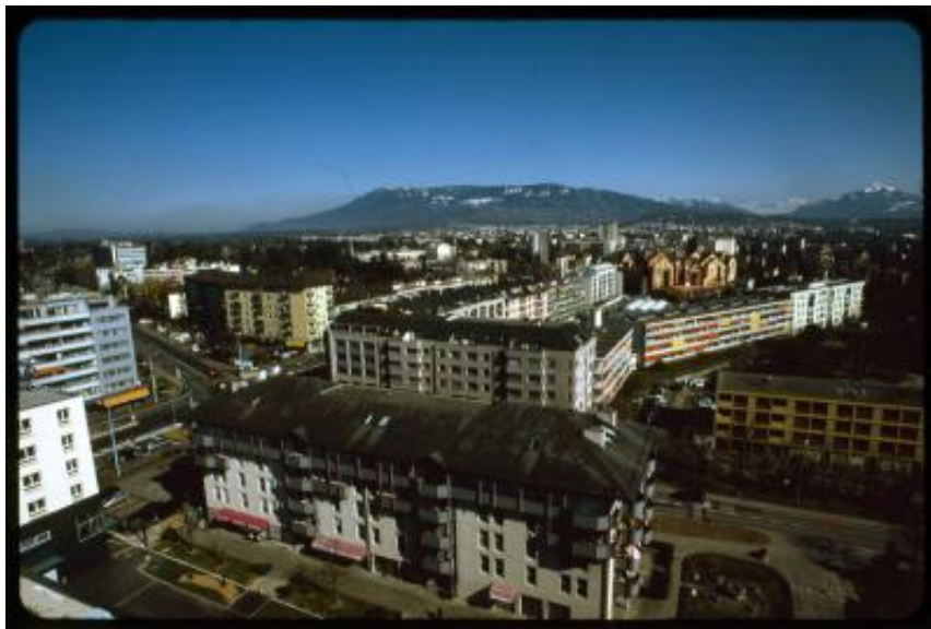
Thônex. Veduta dal tetto del Résidence Apollo
