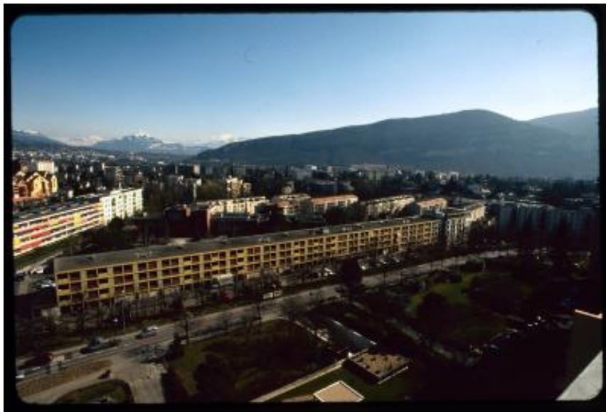
Thônex. Veduta dal tetto del Résidence Apollo
