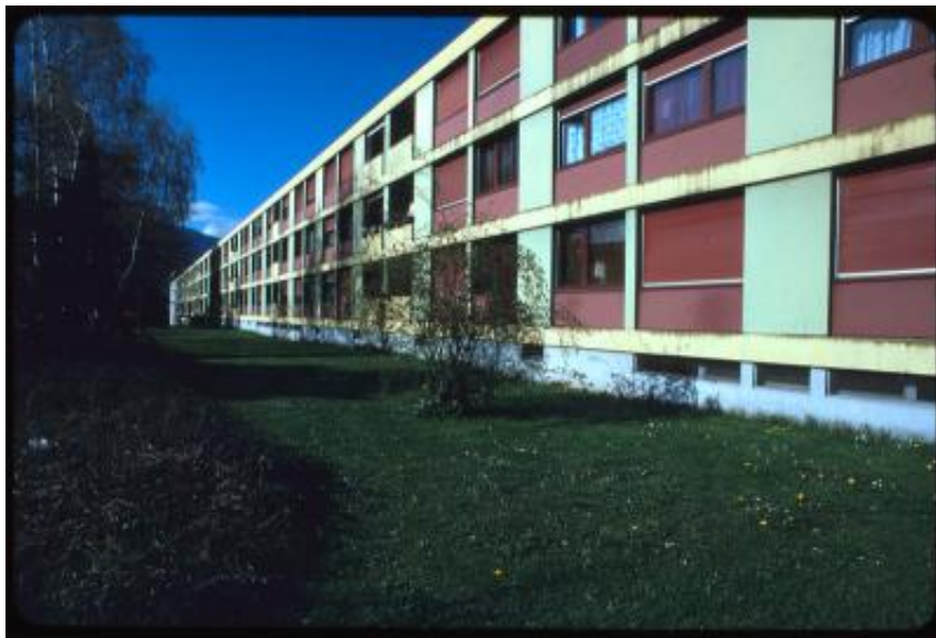
Thônex. Facciata di un edificio in Avenue Adrien-Jeandin
