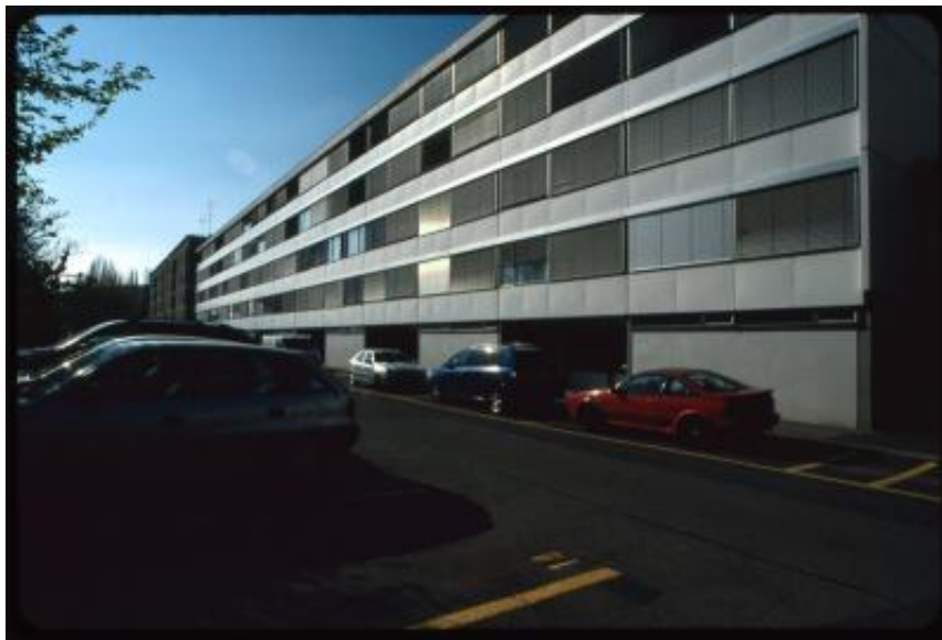
Thônex. Facciata di un edificio sullo Chemin de Chapelly
