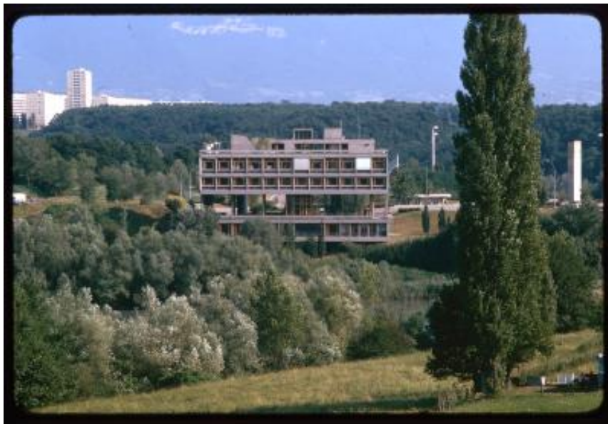
Vernier. Edificio dell'impianto di depurazione nel quartiere Aïre
