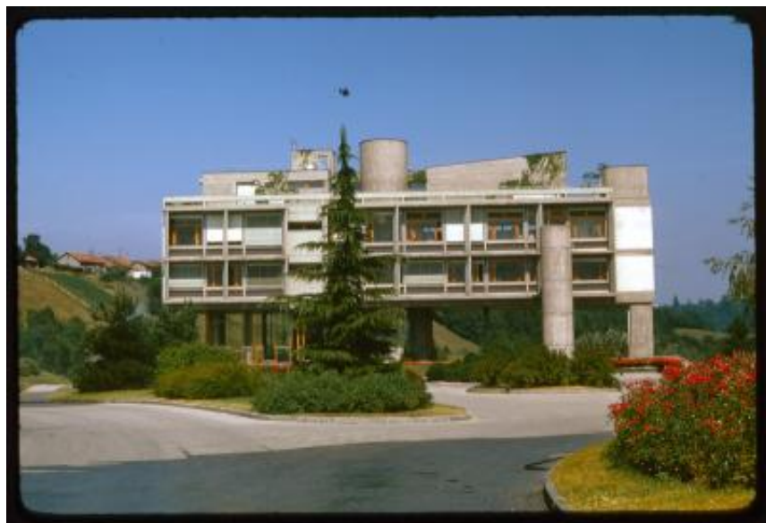
Vernier. Edificio amministrativo dell'impianto di depurazione nel quartiere Aïre
