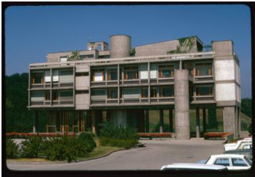
Vernier. Edificio amministrativo dell'impianto di depurazione nel quartiere Aïre
