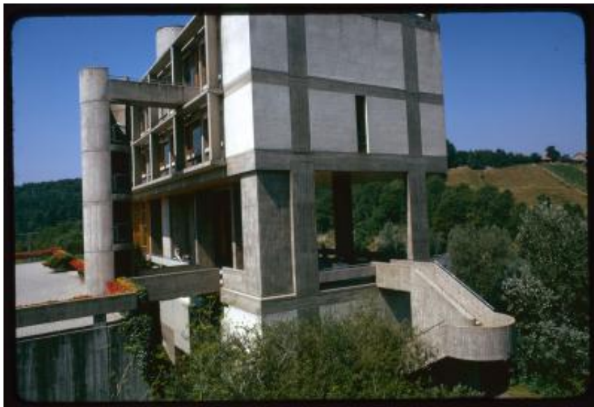
Vernier. Edificio amministrativo dell'impianto di depurazione nel quartiere Aïre, visto lateralmente
