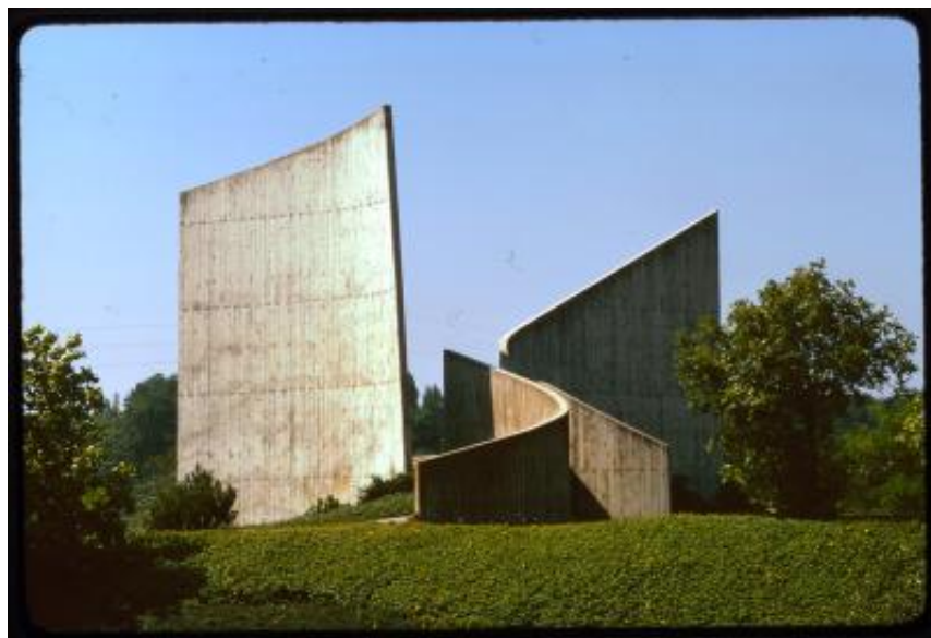
Vernier. Scultura di Jean Baier all'ingresso dell'Impianto di depurazione di Aïre
