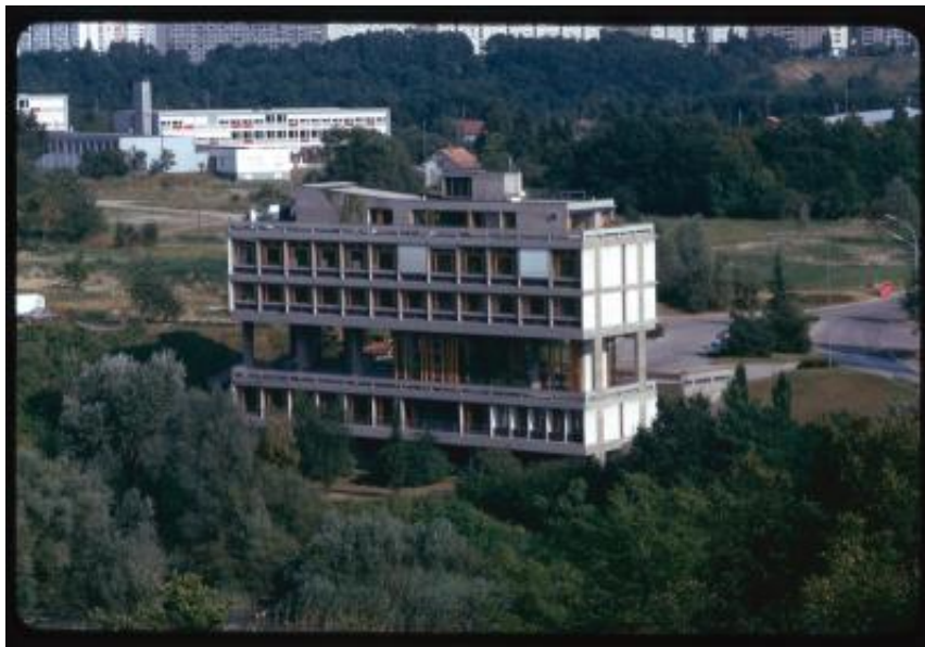
Vernier. Edificio amministrativo dell'impianto di depurazione di Aïre
