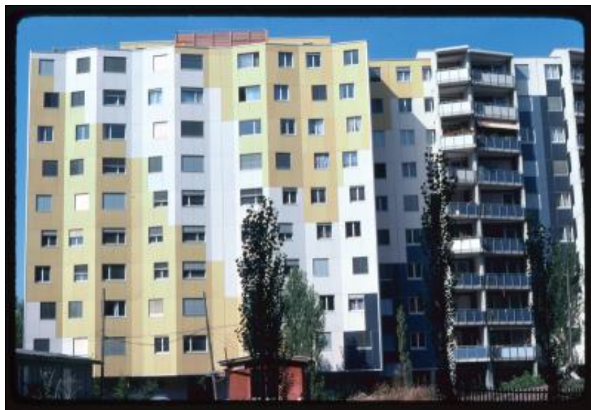
Vernier. Dettaglio della facciata di un complesso residenziale in Avanchet-Parc
