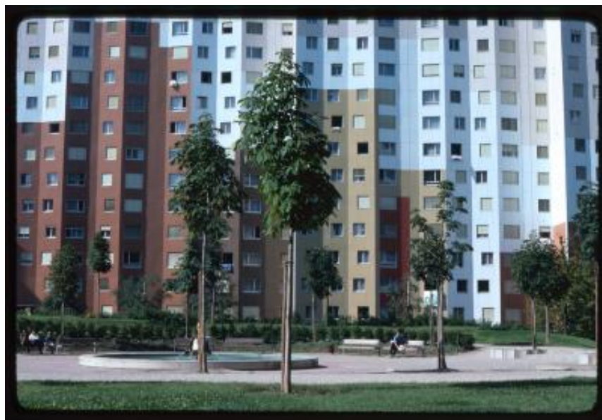
Vernier. Facciata di un complesso residenziale in Avanchet-Parc visto dal giardino
