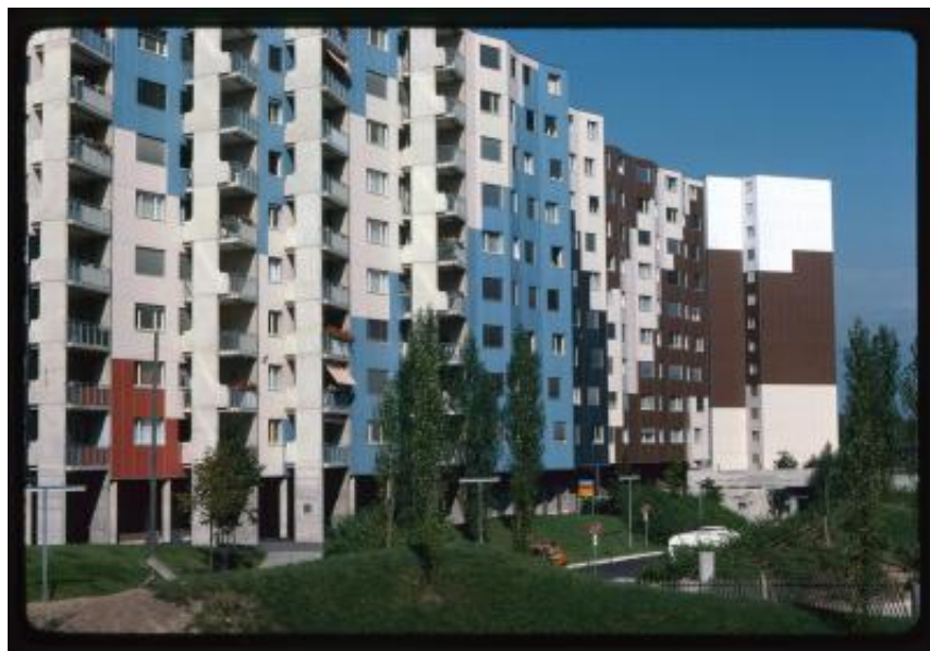
Vernier. Facciata di un palazzo del complesso residenziale di Avanchet-Parc, visto dal giardino
