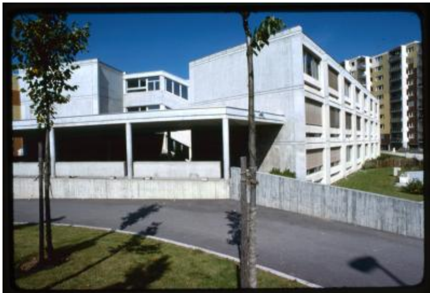
Vernier. Dettaglio della scuola elementare Avanchets-Salève
