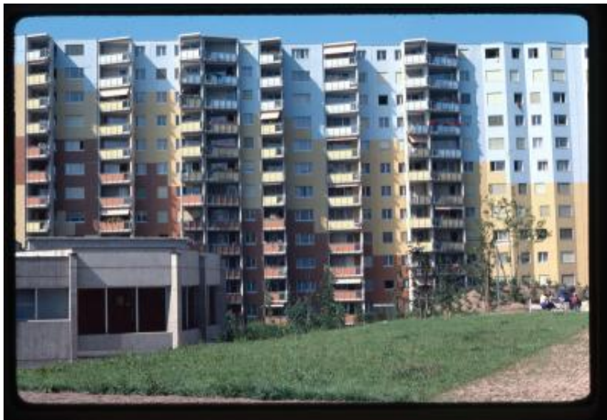
Vernier. Veduta di un palazzo del complesso residenziale di Avanchet-Parc
