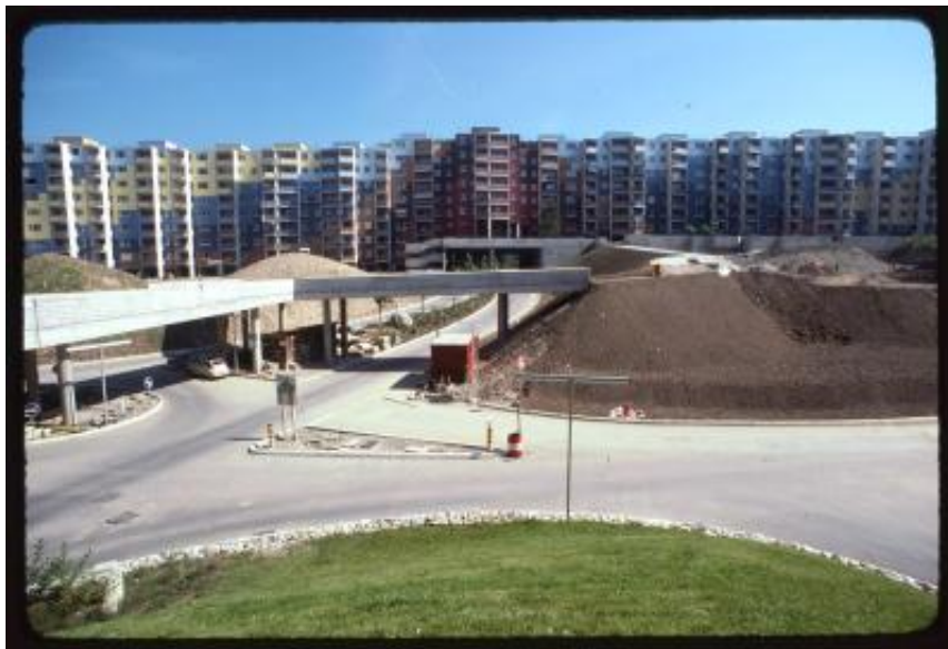
Vernier. Veduta di Avanchet-Parc durante i lavori di realizzazione dei sovrappassi
