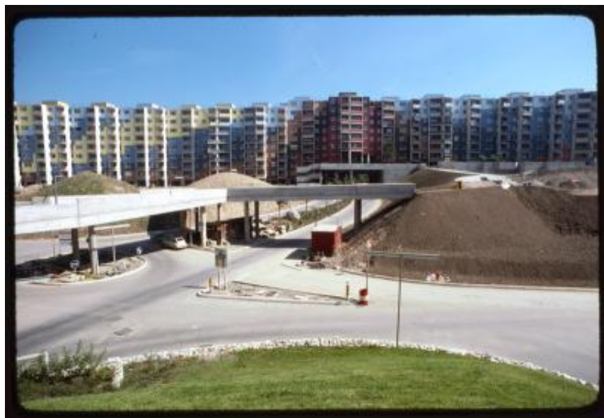
Vernier. Veduta di Avanchet-Parc durante i lavori di realizzazione dei sovrappassi
