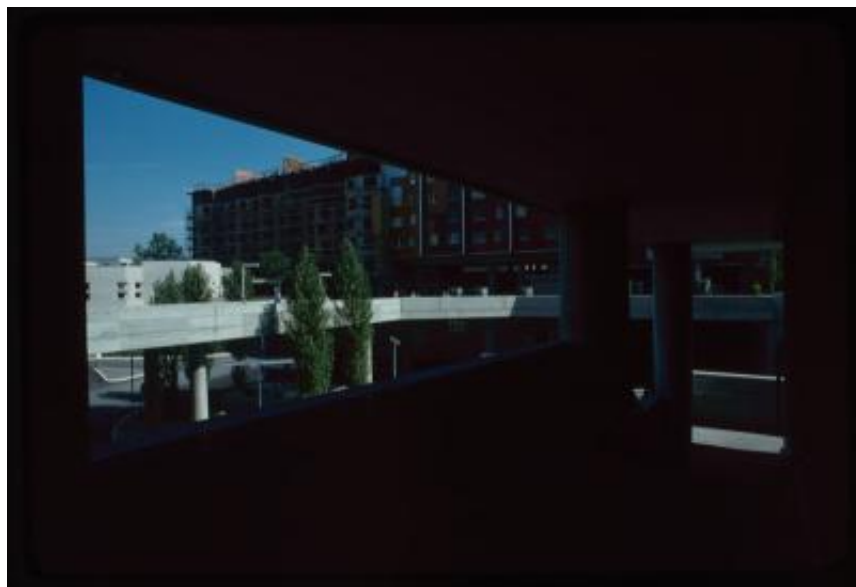
Vernier. Cantiere del complesso residenziale di Avanchet-Parc dall'interno di un edificio
