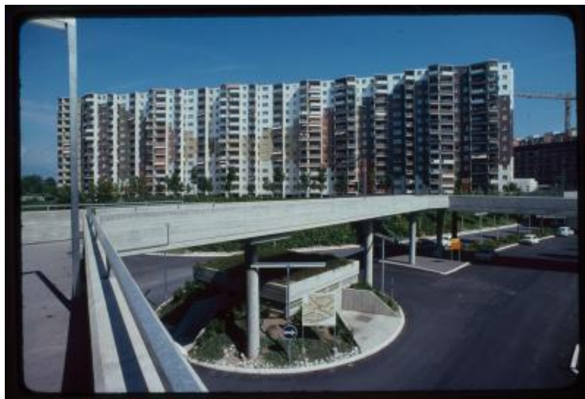
Vernier. Veduta del complesso residenziale di Avanchet-Parc dalla strada di accesso
