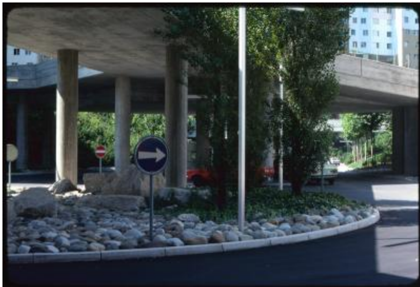
Vernier. Dettaglio di una rotatoria sulla strada d'accesso ad Avanchet-Parc
