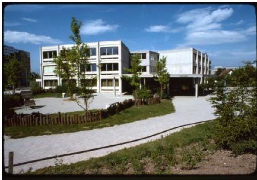
Vernier. Veduta della scuola elementare Avanchets-Salève
