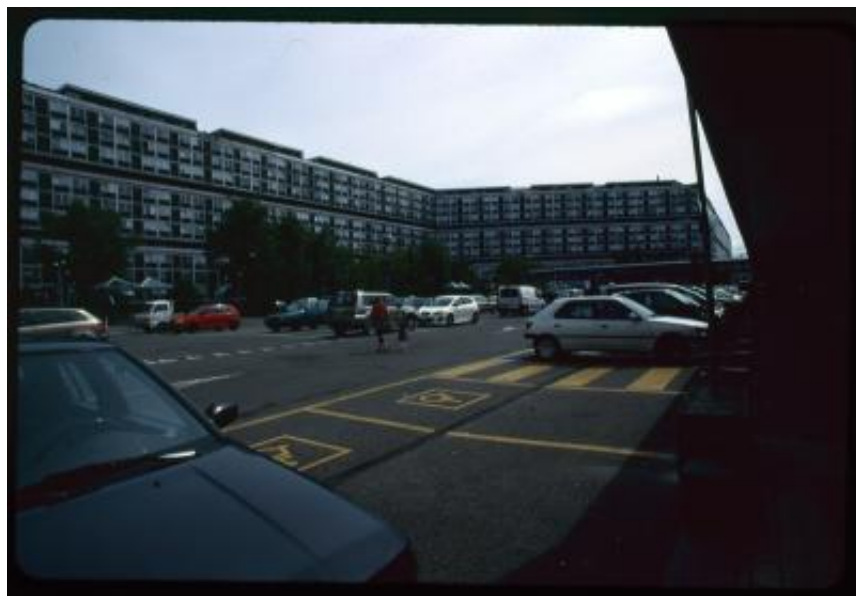
Vernier. Segmento della città satellite di Le Lignon visto dal parcheggio
