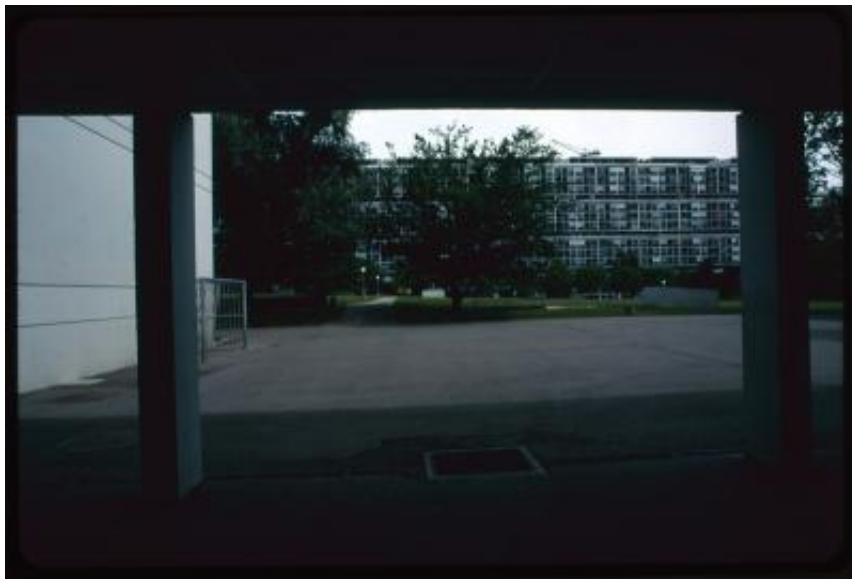
Vernier. Palazzo della città satellite di Le Lignon visto dalla scuola elementare
