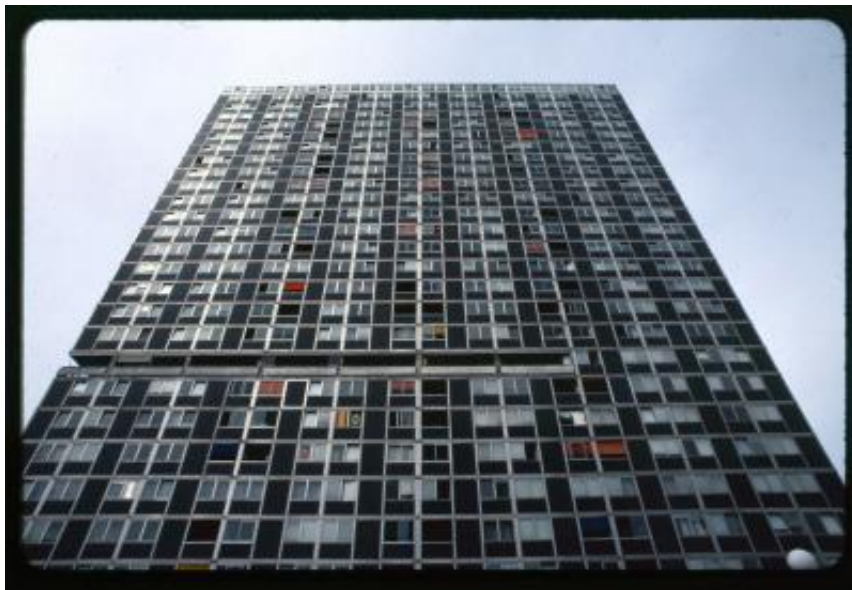
Vernier. Facciata di una delle due Torri della città satellite di Le Lignon
