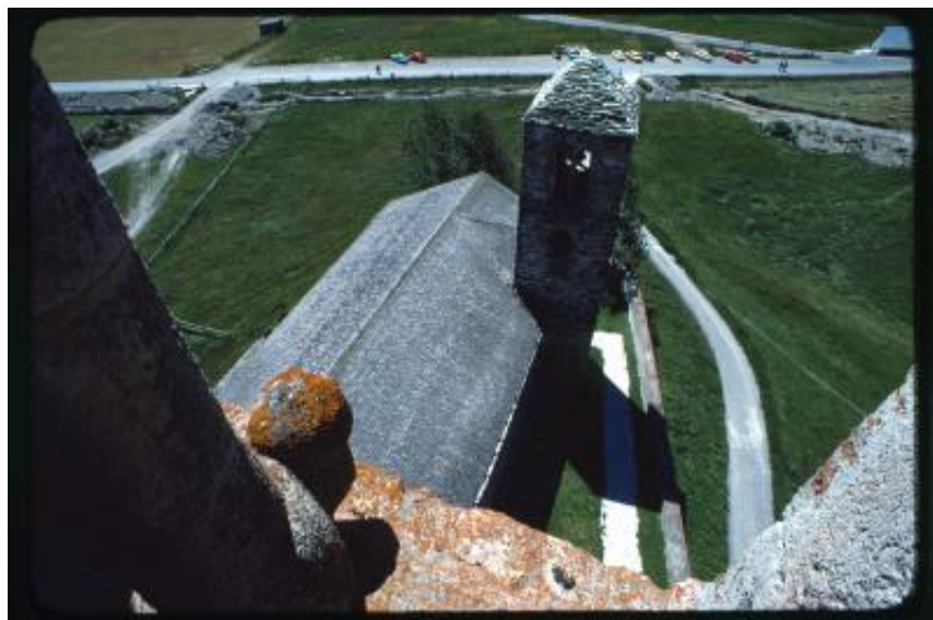
Celerina. Veduta dal campanile del tetto della chiesa di San Gian
