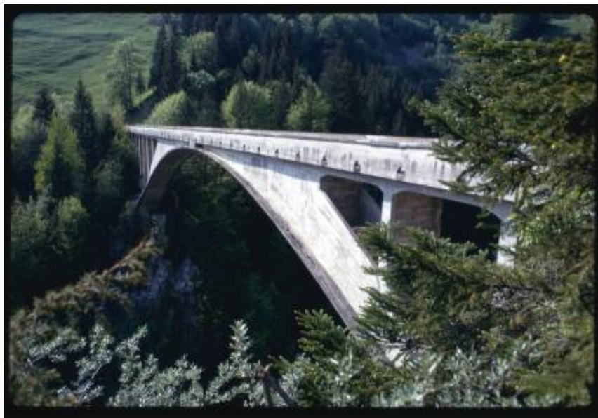
Schiers. Veduta del Ponte Salginatobel
