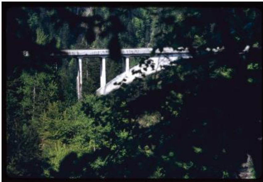
Schiers. Veduta dell'intradosso del Ponte Salginatobel
