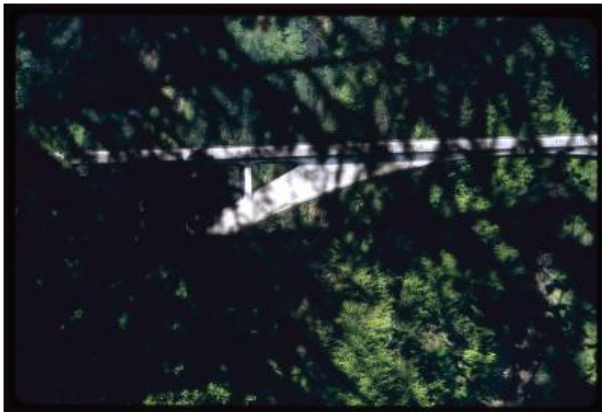
Schiers. Veduta parziale del Ponte Salginatobel
