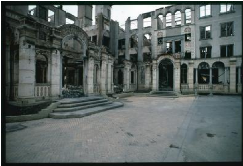
Facciata dell'Hotel Waldhaus di Vulpera dopo l'incendio
