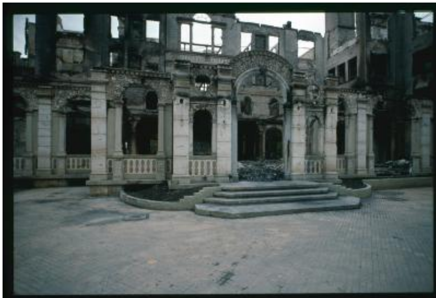
Facciata dell'Hotel Waldhaus di Vulpera dopo l'incendio
