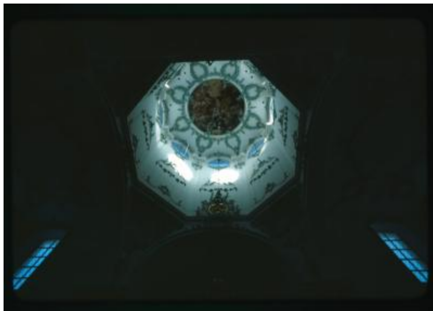
Beromünster. Interno della cupola della Chiesa collegiale di San Michele
