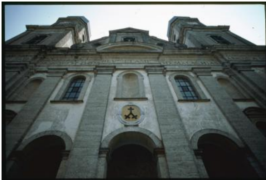
Facciata della chiesa dell'Abbazia di Sant'Urbano a Pfaffnau
