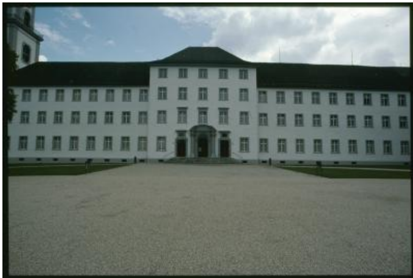
Lato occidentale dell'Abbazia di Sant'Urbano a Pfaffnau
