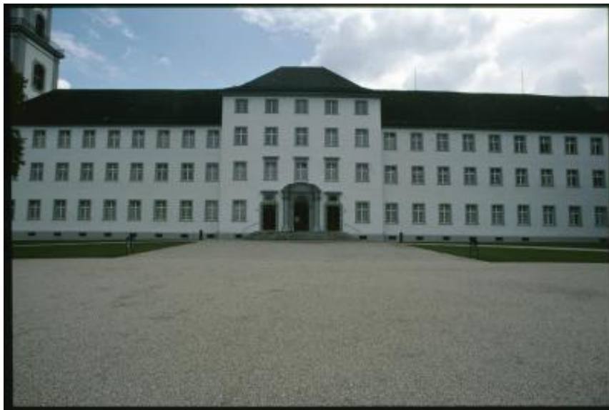
Lato occidentale dell'Abbazia di Sant'Urbano a Pfaffnau
