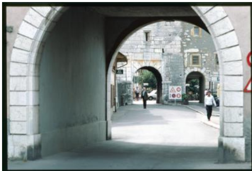
Le Landeron. Passaggio della Torre dell'orologio nel centro storico
