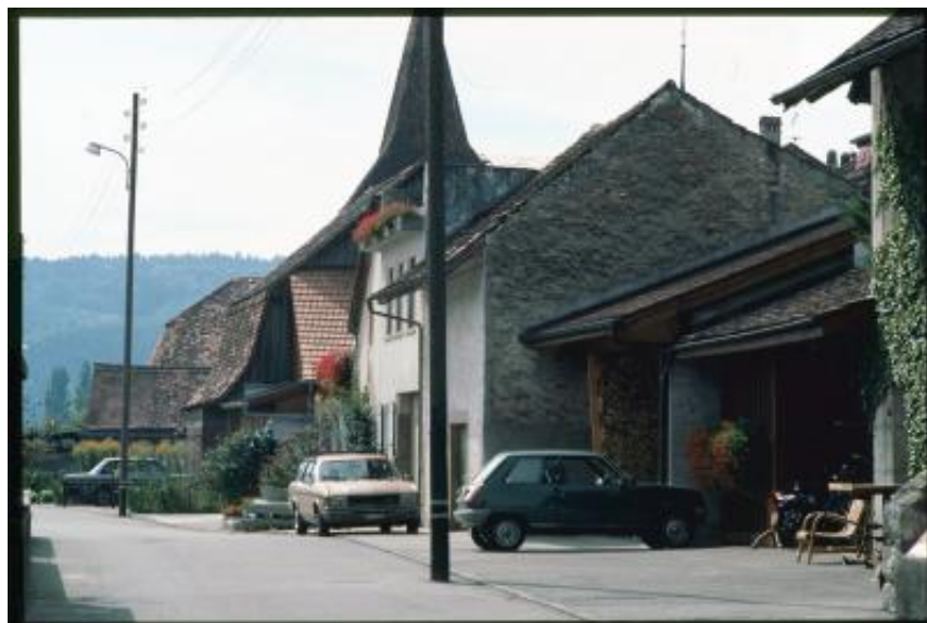
Le Landeron. Facciata esterna degli edifici a est della piazza della "Ville"
