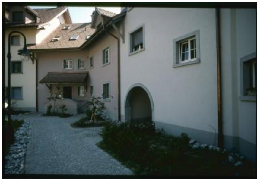
Kaltbrunn. Facciate di un gruppo di abitazioni del quartiere Janahof
