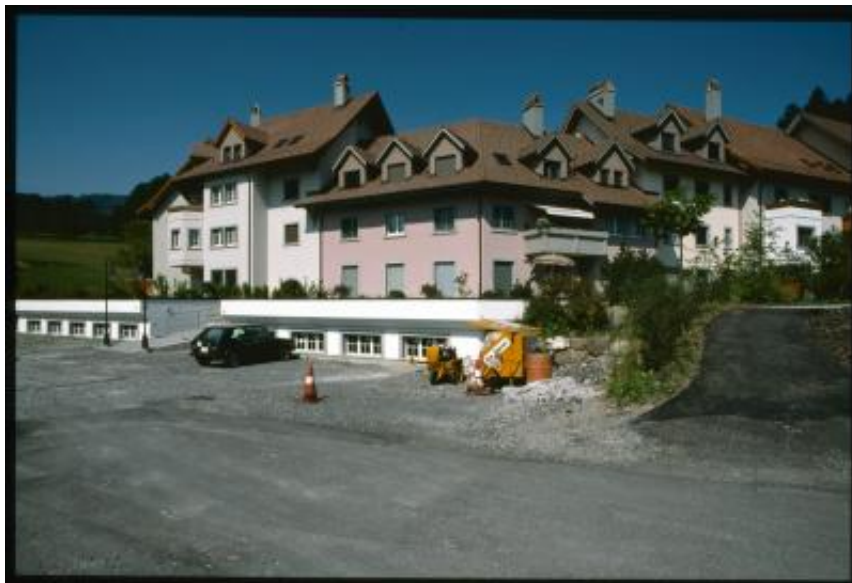
Kaltbrunn. Veduta di un gruppo di abitazioni del quartiere Janahof
