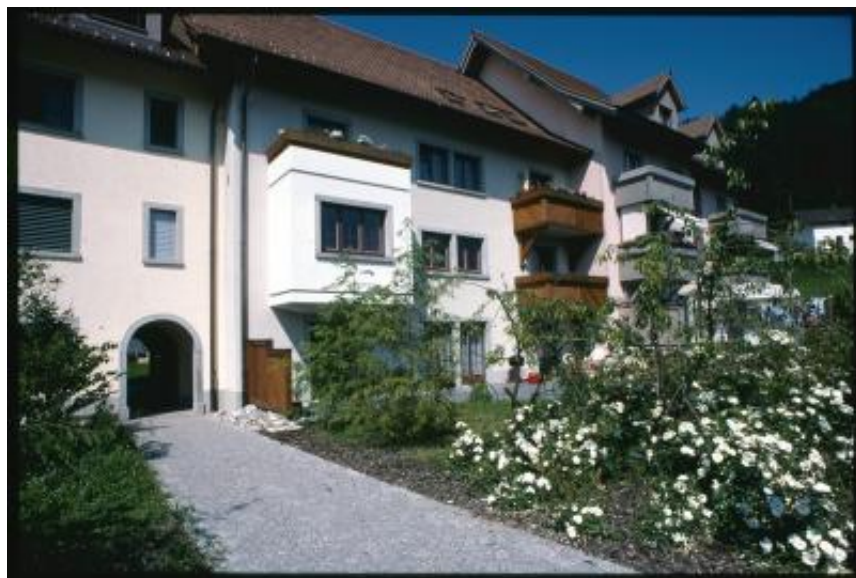
Kaltbrunn. Facciate di un gruppo di abitazioni del quartiere Janahof
