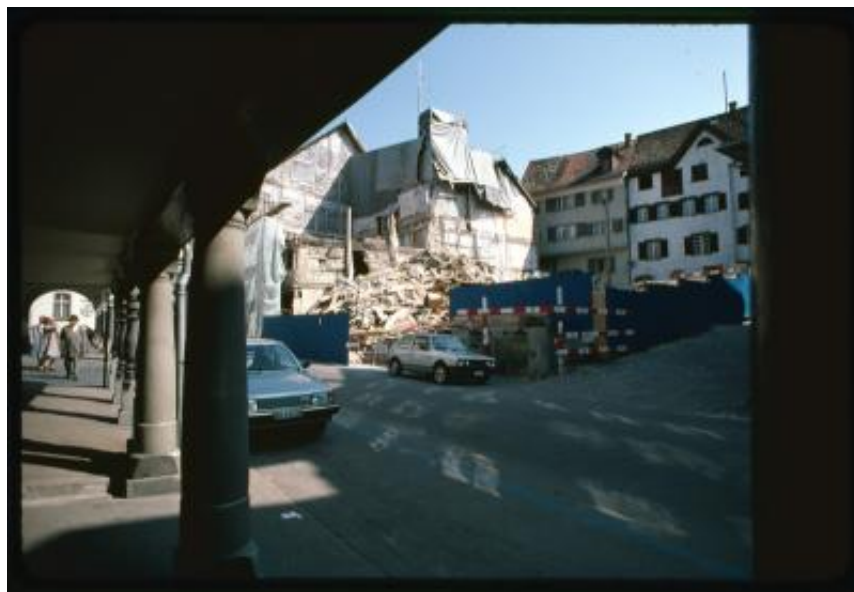
Lichtensteig. Area dell'incendio del 1984 vista dalla strada principale
